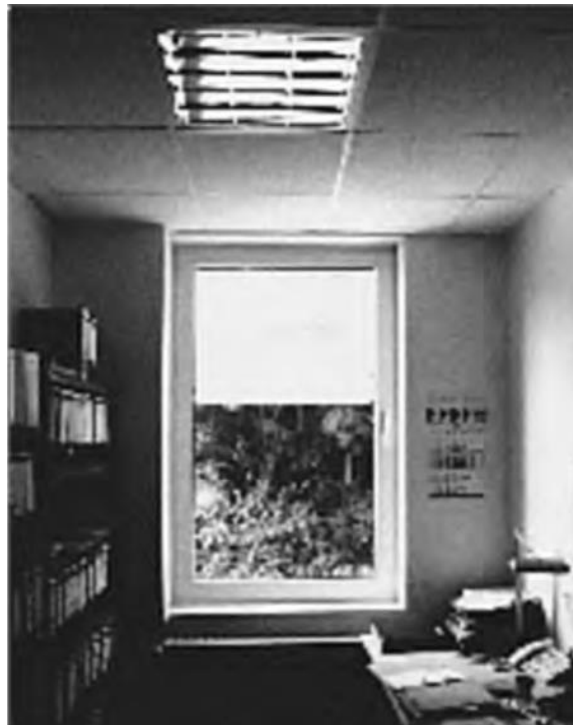
รูปที่ 20 อาคารสำนักงานใช้กระจกนำแสงซินิทีล ในสำนักงาน ADO อาคารไนโคโลญ, เยอรมนี
