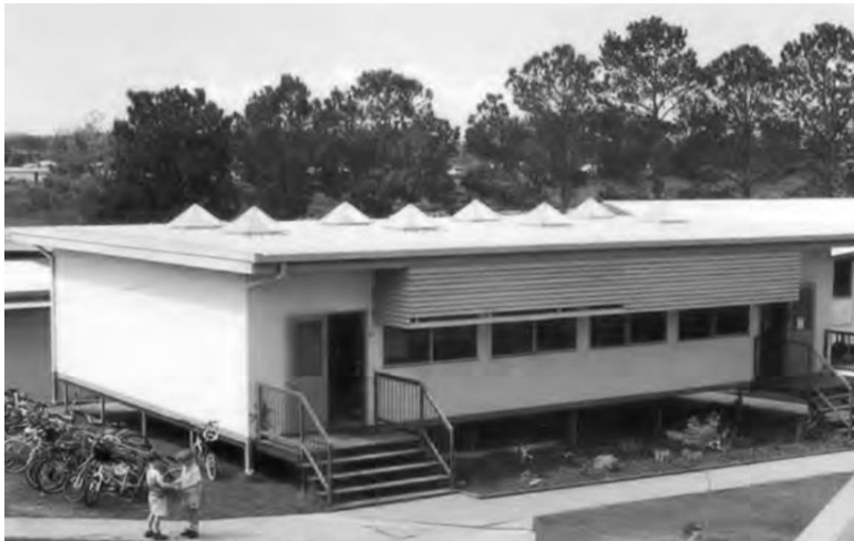
รูปที่ 10 สกายไลท์แบบเลือกมุม โรงเรียนของรัฐวอเตอร์ฟอร์ด บริสเบน ออสเตรเลีย
