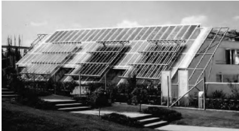
รูปที่ 23 ระบบติดตามความเข้มแสงประยุกต์ใช้กับ Row Houses, ชตุทท์การ์ท, เยอรมนี
