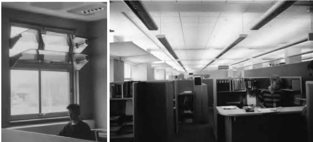
รูปที่ 2 หิ้งสะท้อนแสงแบบกึ่งโปร่งใสสองชั้น ทำมาจากแก้วสะท้อนแสง
