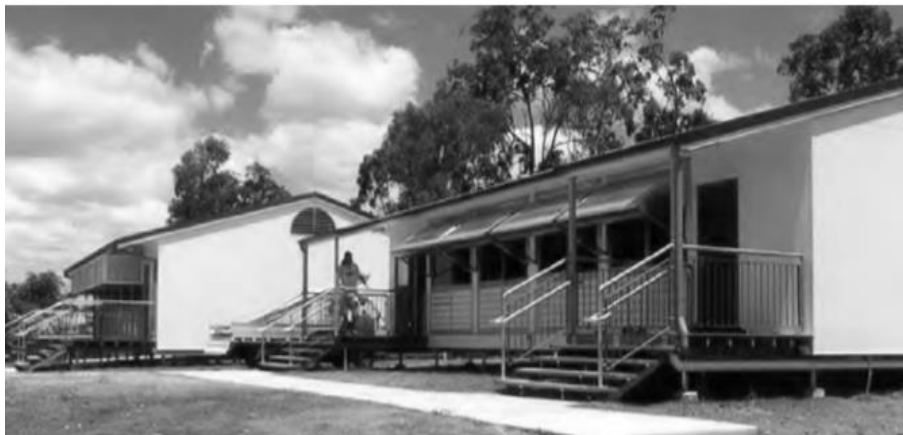
รูปที่ 14 แผงบังแดดที่กำหนดทิศทางแสงของอาคารสวนสาธารณะโรงเรียนบริสเบนออสเตรเลีย
